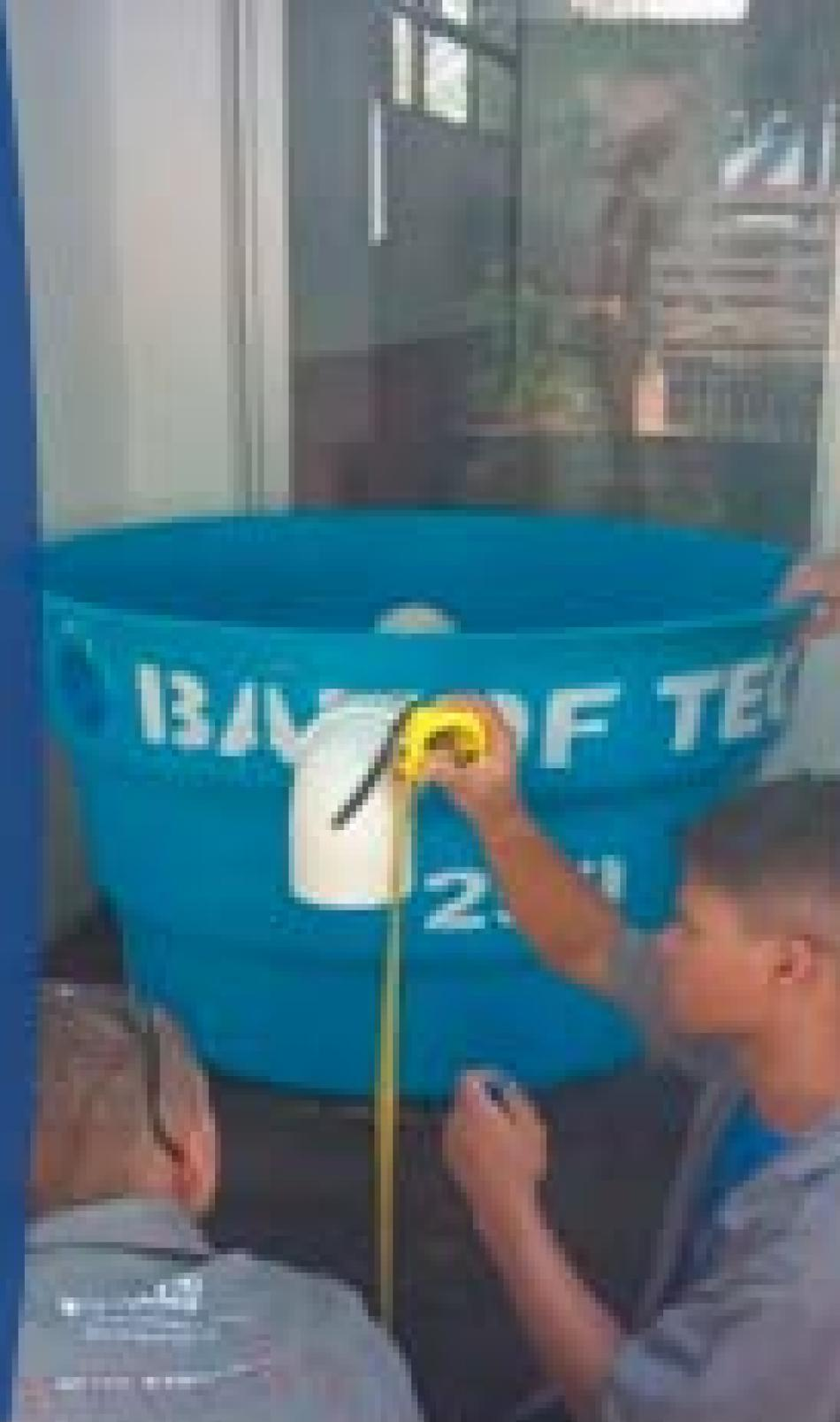
Essa cisterna consistiu em uma ligação da calha do telhado até um reservatório de uma caixa d’água. Dentro dela foi inserido um cano de despejamento para quando encher mais que o limite, direcionar a água fora da caixa. Com o objetivo de manter a caixa sempre cheia para a turma usar e regar suas plantas. No final do projeto, os estudantes tiveram a ideia de fazer um desenho colorido tematizado do fundo do mar na caixa d’água.
