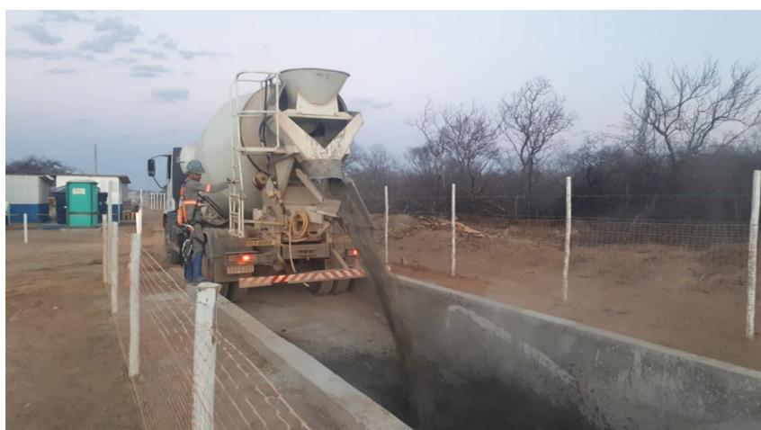
Lavagem do caminhão betoneira no sistema de tratamento físico dos efluentes
