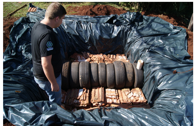
Sistema de tratamento de esgoto modelo BET - Impermeabilização e preenchimento com pneus
