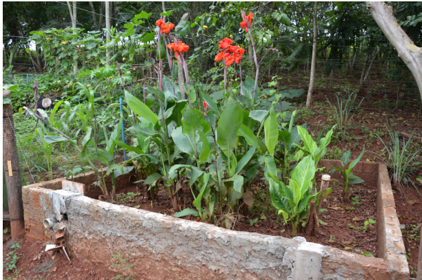
Sistema de tratamento de esgoto em funcionamento
