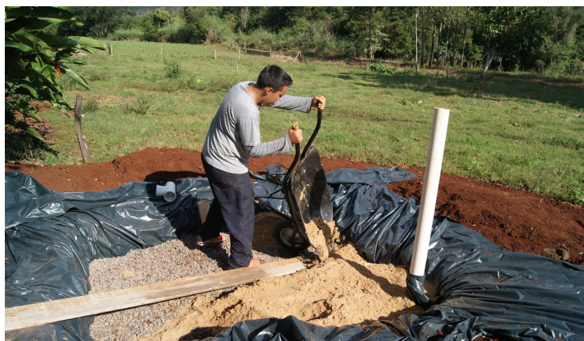
Preenchimento do filtro com entulhos, pedra brita e areia
