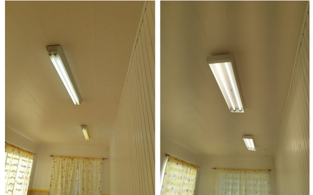
Antes e depois EMEF João Alfredo Corrêa Pinto (Canela)
