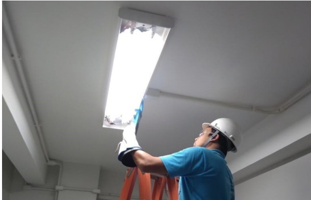
Instalação e medição de lâmpada LED
