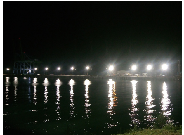
Visão panorâmica do novo sistema de iluminação dos Cais 1 e 2
