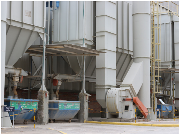
Acondicionamento de pós das aspirações em caçambas
