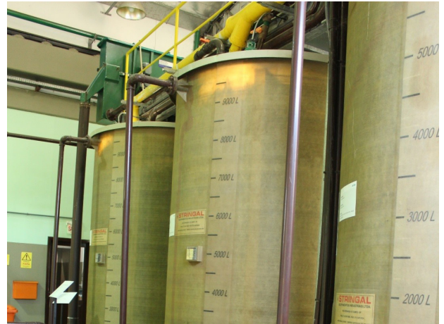
Tanques de acúmulo, equalização e flocodécantador
