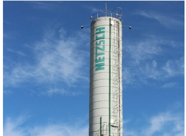
Reservatório elevado que recebe o efluente para posterior reaproveitamento nos vasos sanitários
