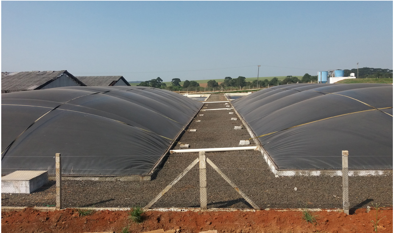
Biodigestor para armazenagem de biogás
