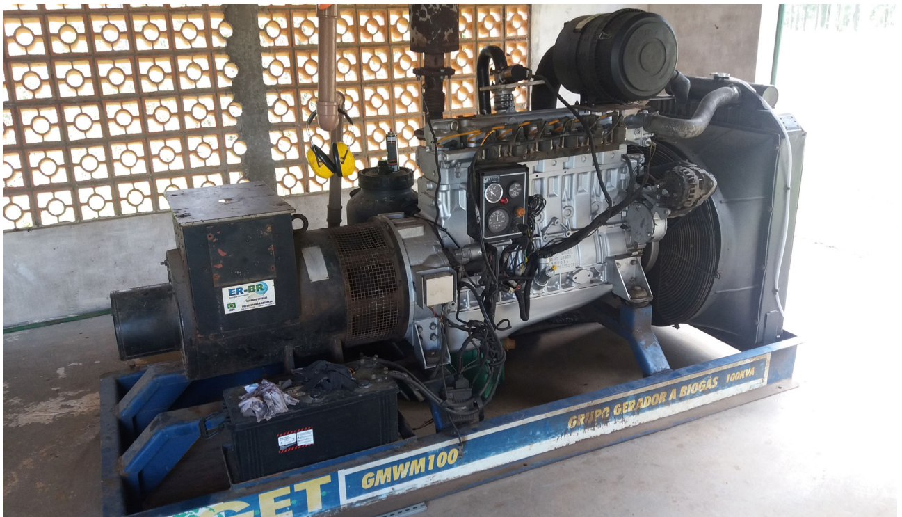
Gerador de energia através de biogás
