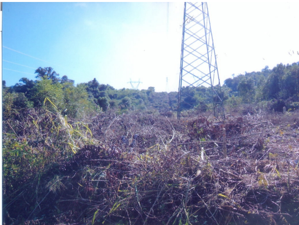
Manutenção no entorno imediato das torres de transmissão de energia
