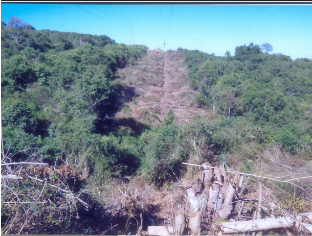
Vista geral das linhas de alta tensão no PERG antes do Projeto IAP/Copel, que evitou o corte raso na encosta acima visualizada por estar a mais de 15 metros da fiação
