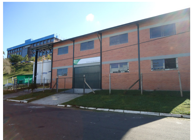
Central de Resíduos
