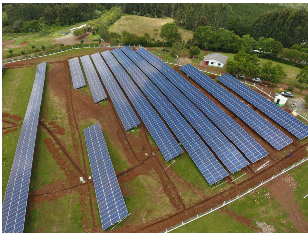
Usina de Energia Solar
