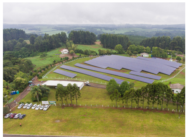
Usina de Energia Solar
