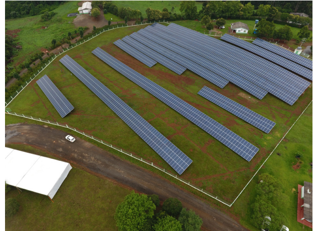
Usina de Energia Solar
