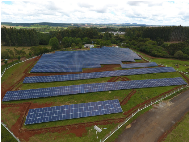
Usina de Energia Solar
