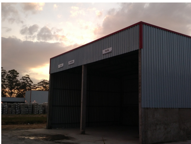
Novas instalações central de resíduos
