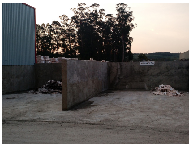
Novas instalações boxes de resíduos industriais
