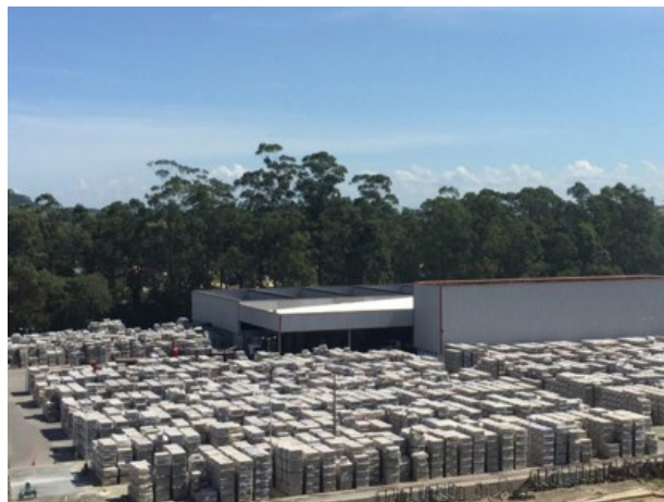
Adequação pátio fabril
