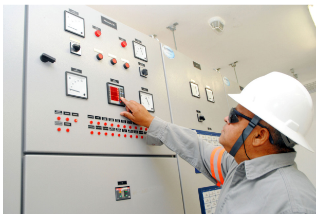
Celesc distribui energia para 264 dos 295 municípios catarinenses (Foto: Subestação Curitibanos. Jaqueline Noceti / Secom SC)
