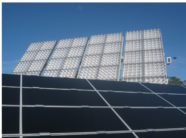
Detalhe do Módulo de Avaliação instalado no Parque Ambiental Tractebel
