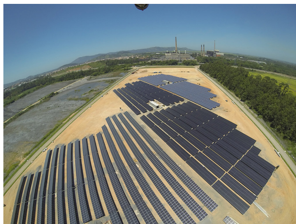
Vista aérea da Usina Fotovoltaica Cidade Azul
