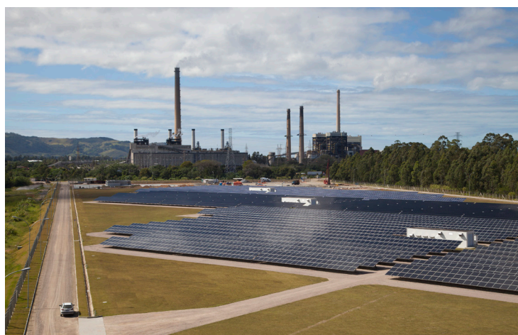
Usina Fotovoltaica Cidade Azul fica ao lado do Complexo Termelétrico Jorge Lacerda
