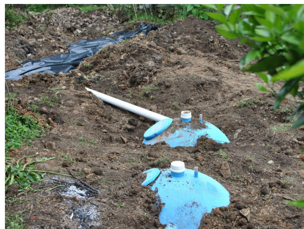
Destino adequada das águas servidas - Programa Água Limpa
