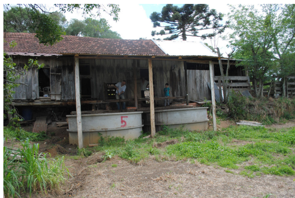
Instalação de esterqueiras - Programa Água limpa
