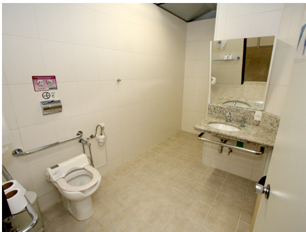
Todos os banheiros são equipados com torneiras automáticas e descarga nas bacias sanitárias com dois fluxos de água
