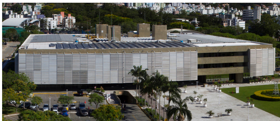
Nas laterais da sede da Eletrosul há brises para bloquear a radiação do sol e no telhado estão os dômus para aproveitamento da iluminação natural e placas fotovoltaicas da Usina MegaWatt Solar
