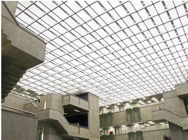
Iluminação natural através de dômus no teto da edificação
