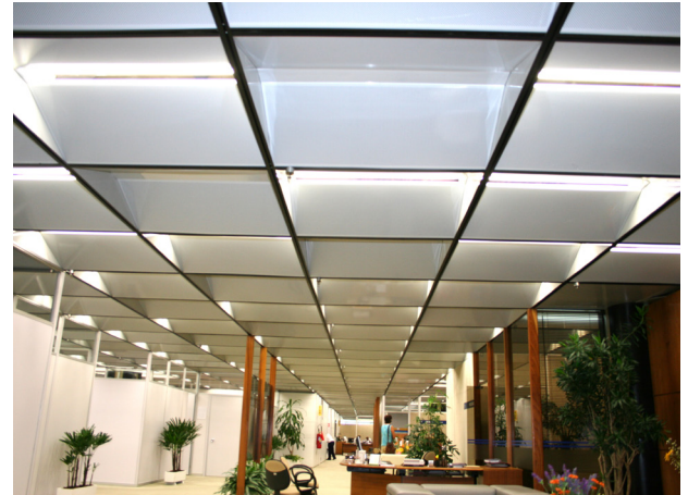
A iluminação artificial é composta por lâmpadas fluorescentes T5 que possuem maior rendimento luminoso
